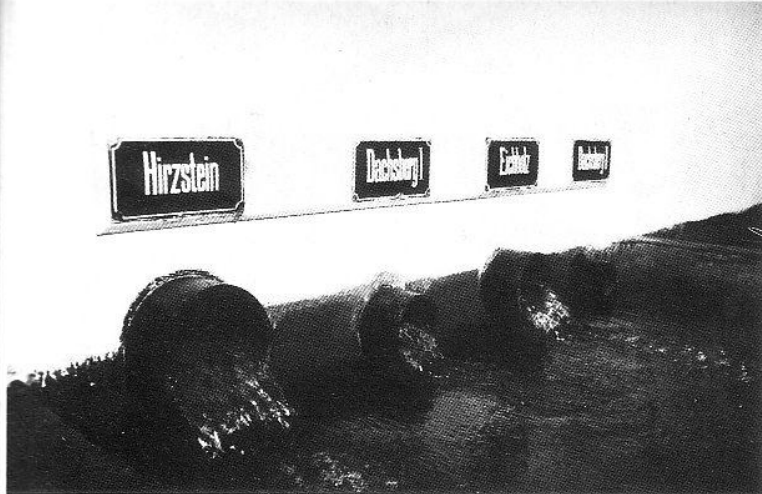
Innenansicht einer Quellsammelstube (Archiv Städtische Werke AG)
