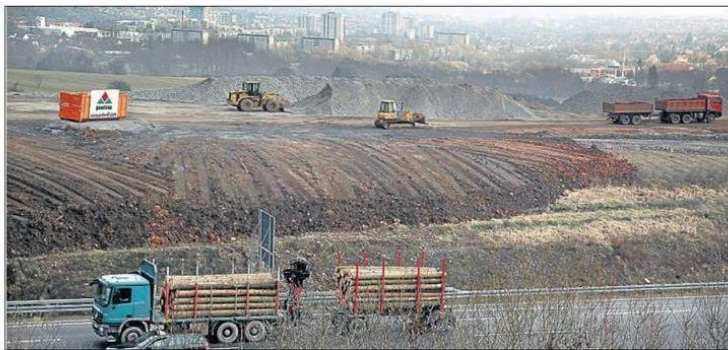
Seit 2009 wird der Wall entlang der A44 zwischen Altenbaunaer Straße und Autobahnrastplatz Baunsberg aufgeschüttet. 2016 soll er fertig werden. Er wird dann doppelt so groß sein wie der 2011 fertiggestellte Wall bei Oberzwehren mit 750 Metern Länge und einem Volumen von 485 000 Kubikmetern.
