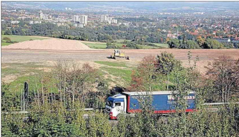
Erdwall an der A 44: Die Aufschüttung ging durch die Großbaustellen um Kassel - Flughafen, SMA - schneller als erwartet. Ob der Wall, der auch für Lärmschutz sorgen soll, fortgesetzt wird, ist fraglich. Archivfoto: Koch
