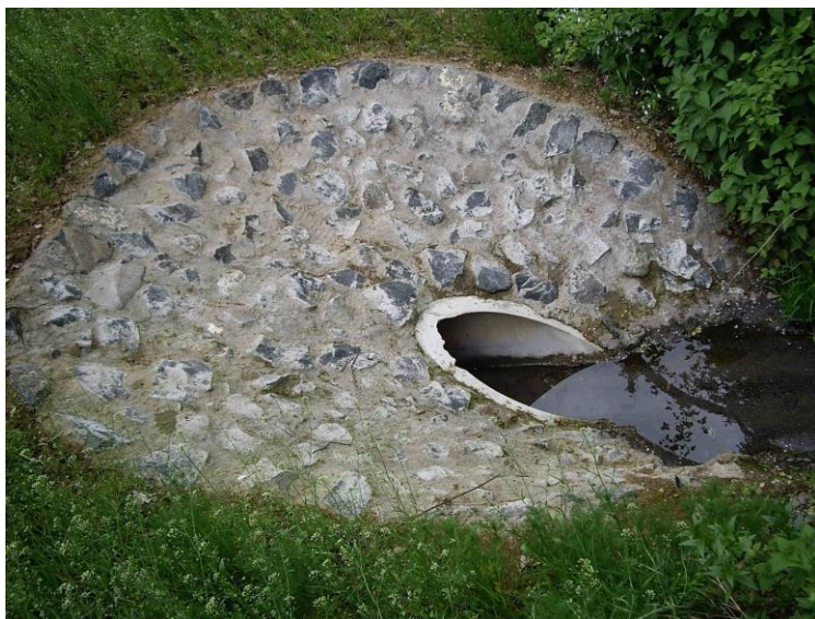
Die Verrohrung unter der Autobahn.
