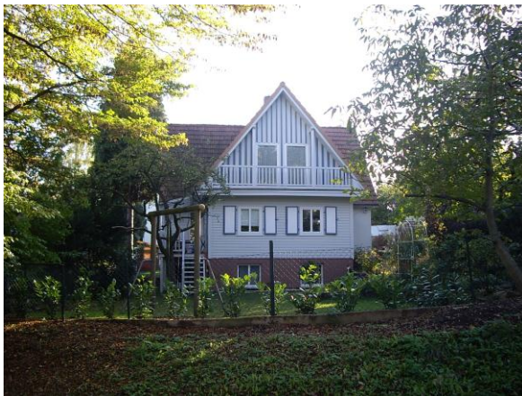
Nordshäuser Straße 6b
