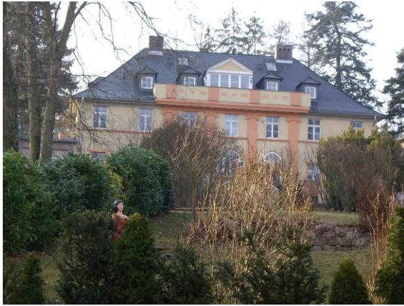
Wiederholdstraße 22 Ansicht von Osten
