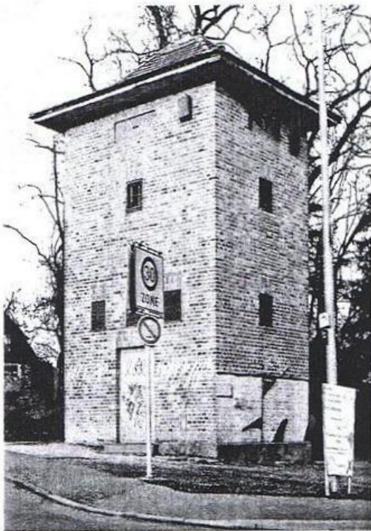
Nordshäuser Straße o. Nr. – Trafostation
