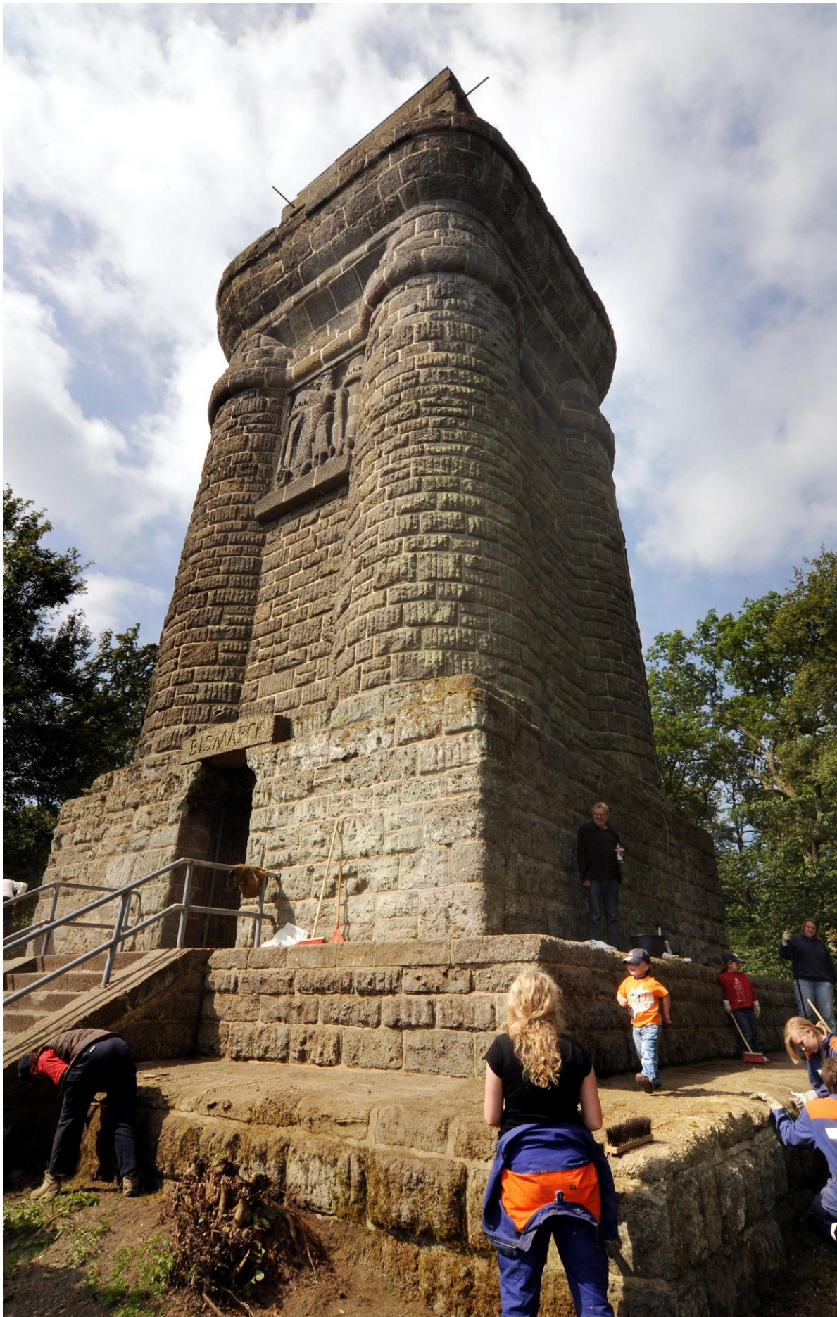
Der Turm ca. 1 Stunde nach Arbeitsbeginn. Fortschritte sind deutlich sichtbar. (Foto Pia Malmus)
