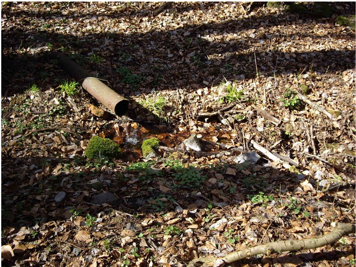
Brunnenauslauf. Das Wasser aus dem Bergwerk war (und ist) als Trinkwasser unbrauchbar
