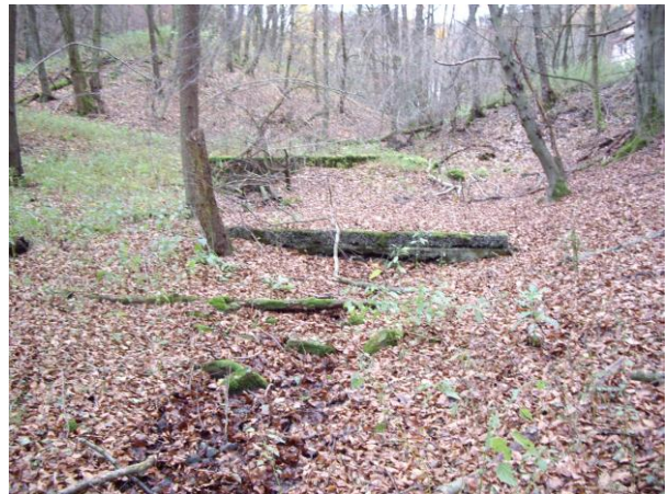
Alte Stauanlagen (Sandfang) u. Trockenfall
